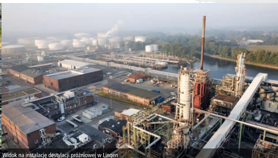
Widok na instalację destylacji próżniowej w Lingen
