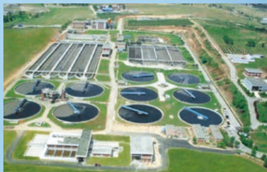
Oczyszczanie ścieków w Stambule jest gigantycznym zadaniem, które jest codziennie realizowane w 51 instalacjach
