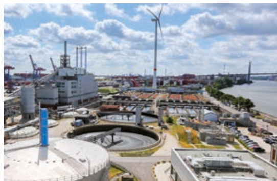
Pomyślnie przetestowana instalacja powstaje na terenie oczyszczalni ścieków w Hamburgu
