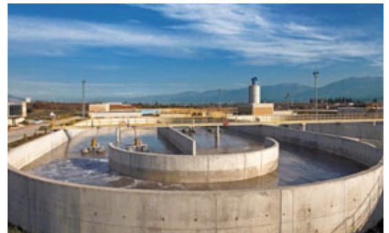
Bis zu 80.000 Kubikmeter Wasser täglich bereitet REMONDIS in jeder der betriebenen Anlagen wieder auf
