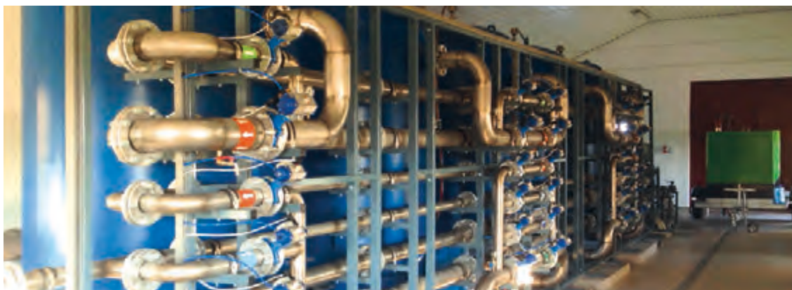
Także w Kobylnikach technika instalacyjna gospodarki wodnej jest na najwyższym poziomie
