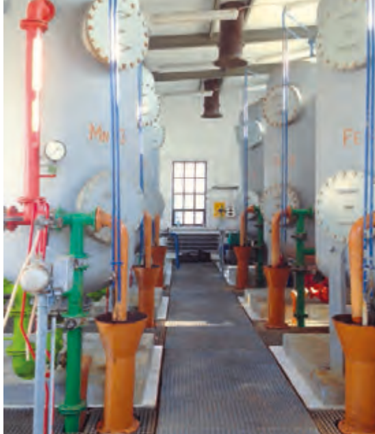
Przedsiębiorstwo wodne w Wyszogrodzie przeszło kompleksową modernizację
