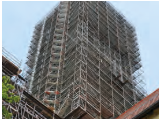
Konstrukcja rusztowania XERVON na bazylice w Ambergu została bardzo szczegółowo zaplanowana i obliczona – jest to imponujący przykład fachowego ustawiania rusztowań
